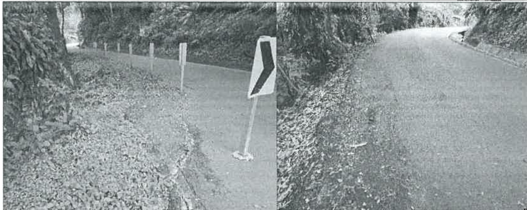
Figura 5: Deformación de la vía en la ruta nacional 135, punto evaluado 2. Gritas en carril que muestran el proceso activo de deslizamiento.
