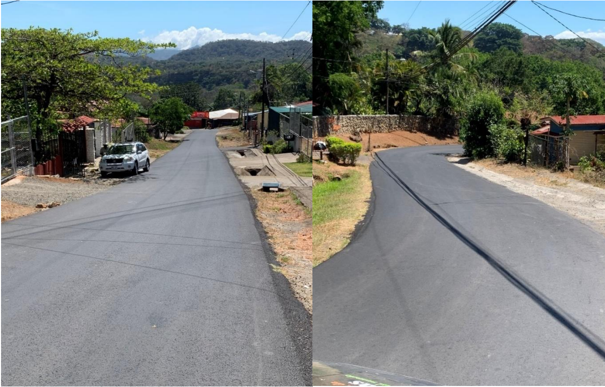
Calle Pósitos, código 2-05-037, colocación asfalto, 200ml y 5m de ancho
